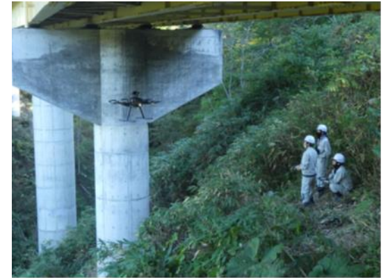
写真④ ドローンを活用した橋梁点検（豊橋橋〈豊富町〉）
