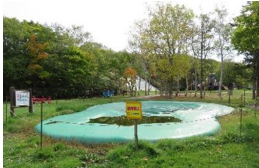
写真① 遊具の立ち入り禁止措置状況（宗谷ふれあい公園〈稚内市〉）
