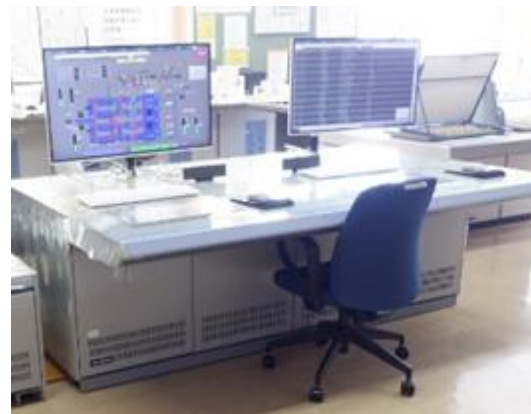
写真② 中央監視装置改築工事（十勝川流域下水道〈帯広市〉）
