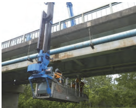
橋梁の定期点検の実施状況
