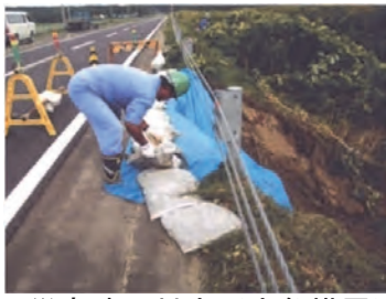
災害時の対応（応急措置）
