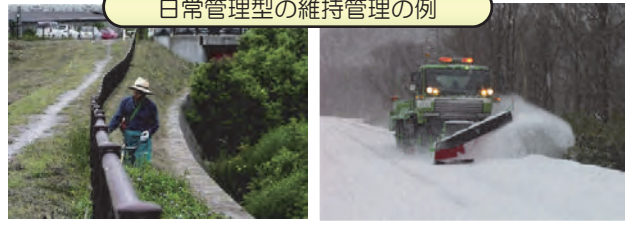
堤防の草刈り
