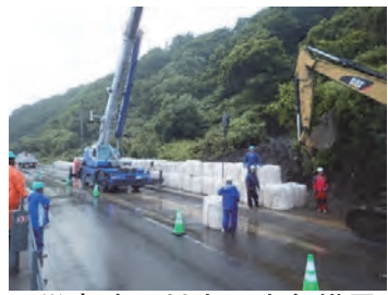
災害時の対応（応急措置）
