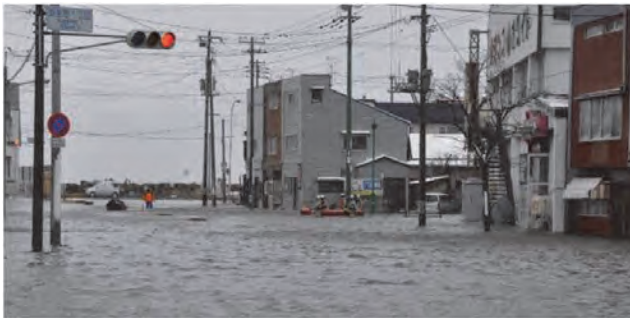
高潮による被害状況 (H26(2014).12 根室市) 国土交通省：気候変動を踏まえた海岸保全のあり方検討委員会(第1回)資料2 P7より引用
