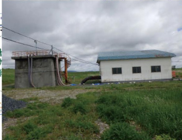
排水機場全景
