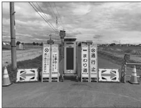
ソーラー電光表示板の使用
