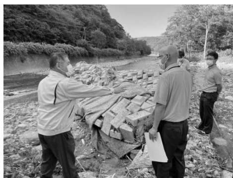
被災現場確認
