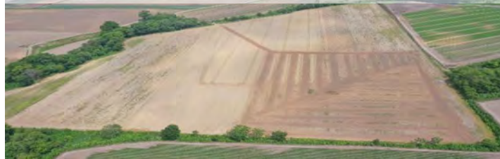
改良山成工・暗渠排水整備後の農地（畑）
