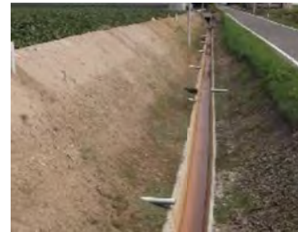
排水路・暗渠排水を整備
