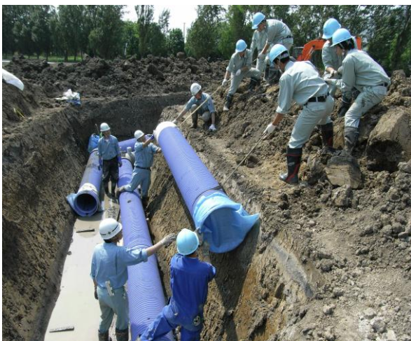
(地中で熱交換するため、パイプを敷設)
