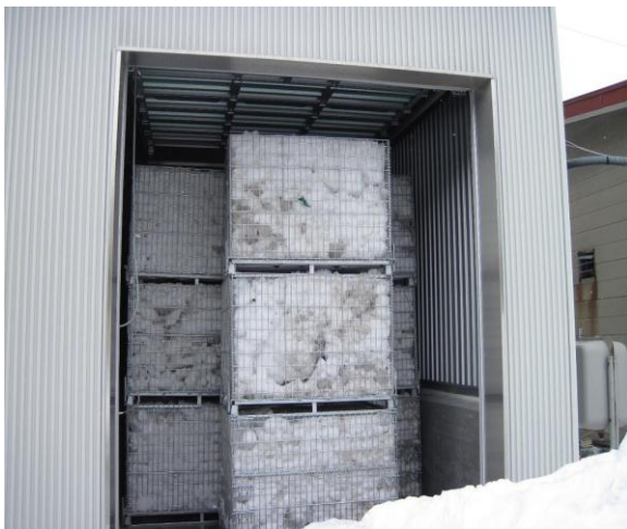
荷捌所雪貯蔵室
