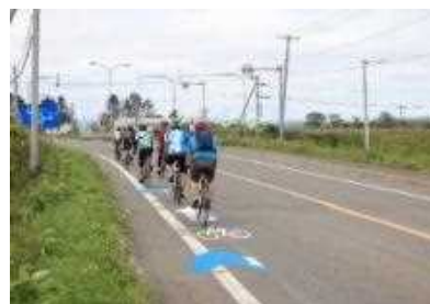
路面への通行位置明示
