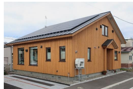
太陽光パネルを設置したZEH※の例
