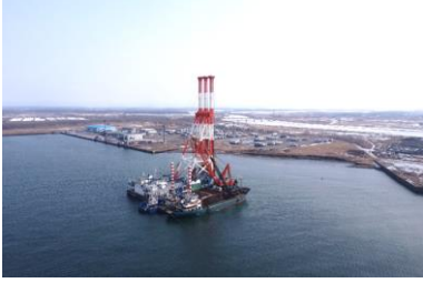
苫小牧港 東港 周分ふ頭 耐震強化岸壁 地盤改良状況
