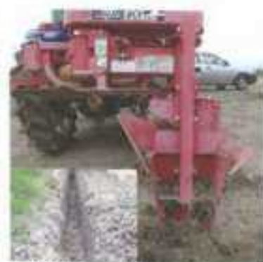
写真3 溝掘機の施工
