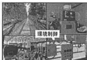
施設環境計測・施設環境制御
