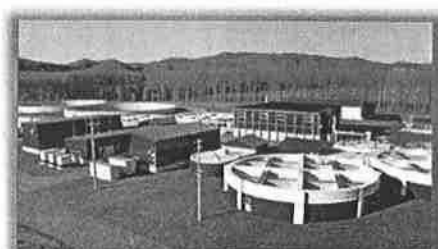
バイオガスプラント(鹿追町)
