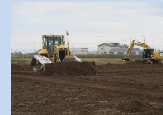
基盤整備事業によるほ場の大区画化
