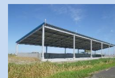
公共牧場の規模拡大に向けた堆肥舎の建設
