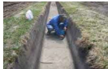
水路の目地補修
