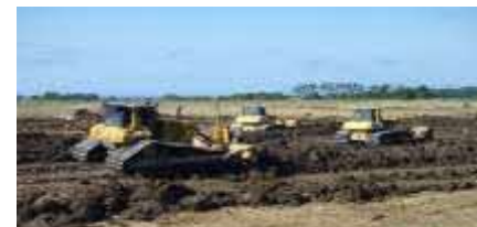
工事中: 区画整理 施工状況(別苅地区)
