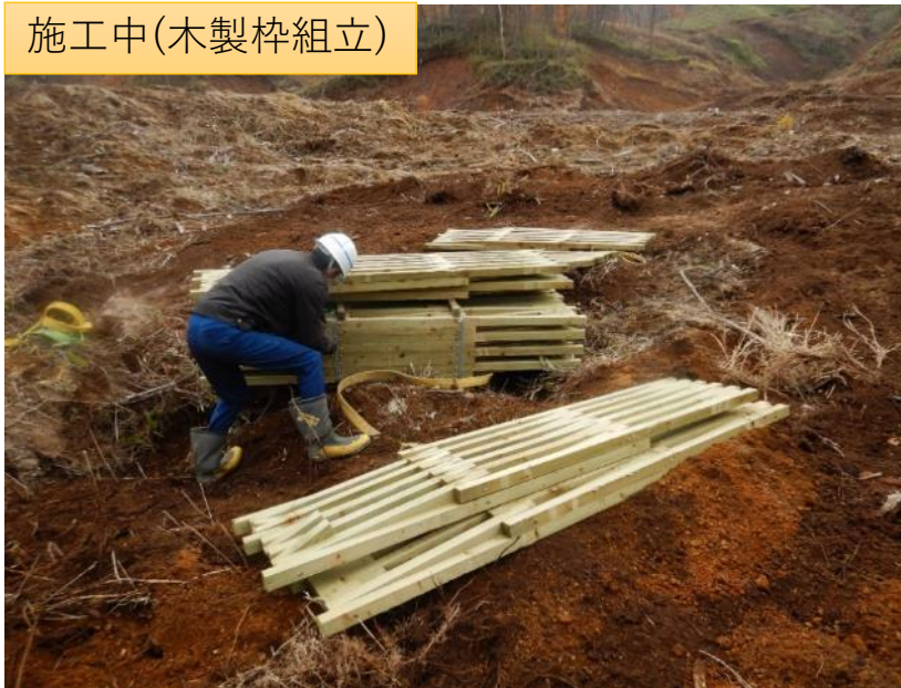
施工中(木製枠設置)
