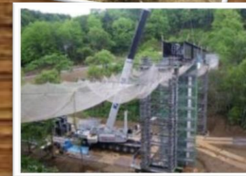
担当した工事の様子
