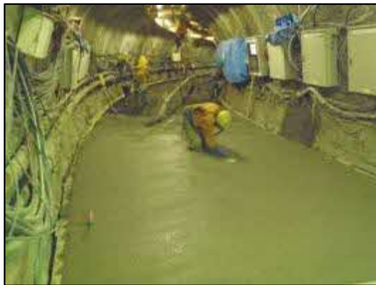
路盤コンクリート打設
