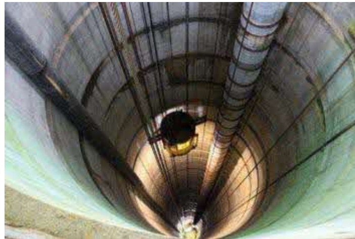
直径6.5m (西立坑)
