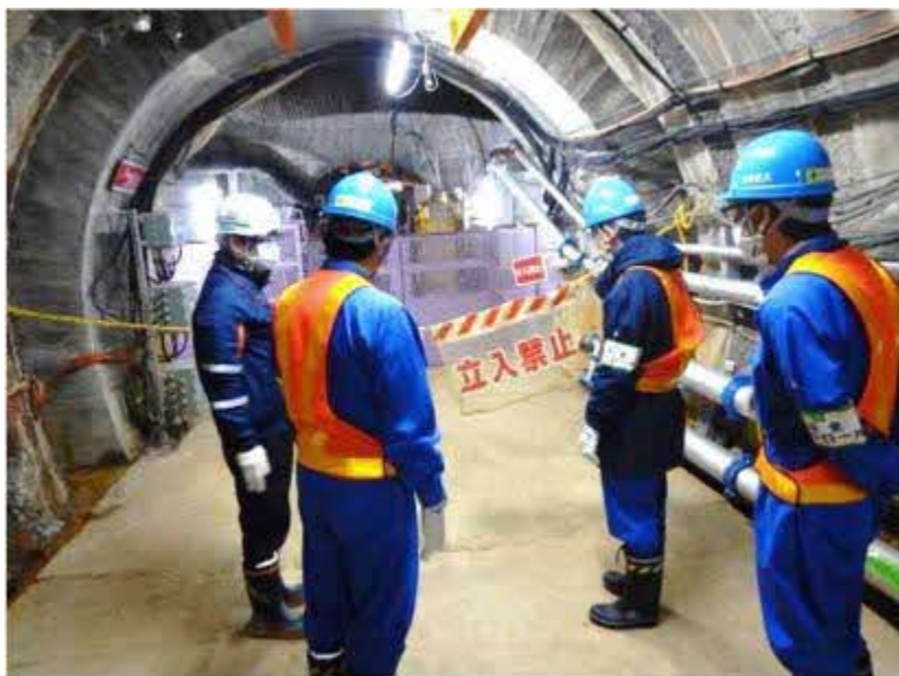
安全パトロールの様子
