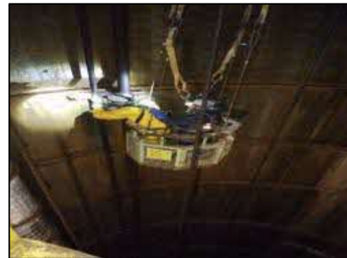
配管・配線作業
