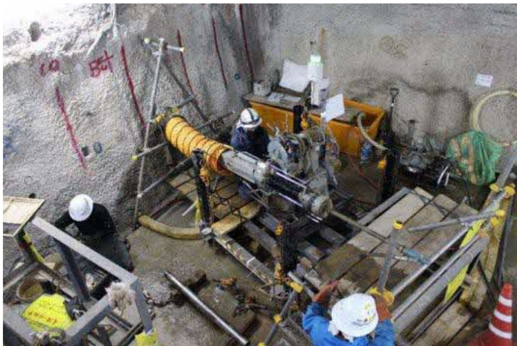
ボーリング調査の様子 (250m調査坑道)
