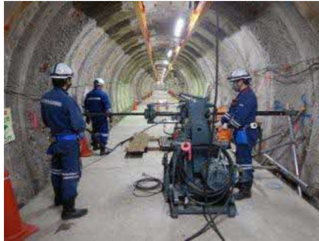
先行ボーリング
