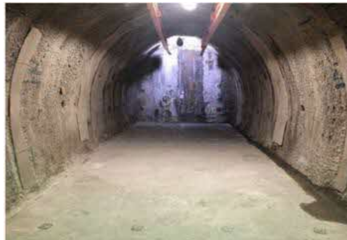
試験坑道の例 (試験坑道1)
