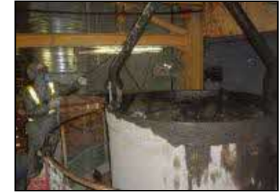
③掘削土(ズリ)出し
