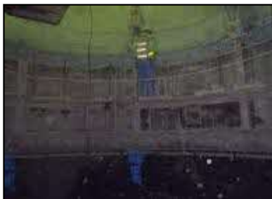
⑦型枠セット
