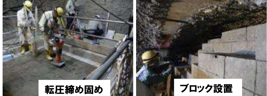
坑道の埋め戻し(下部:転圧締め固め、上部:ブロック設置)
