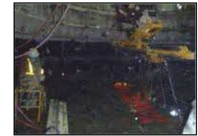
⑥ロックボルト設置
