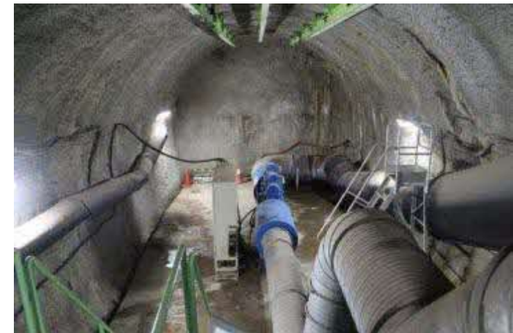
ボーリング横坑の例 (250m) 20/65
