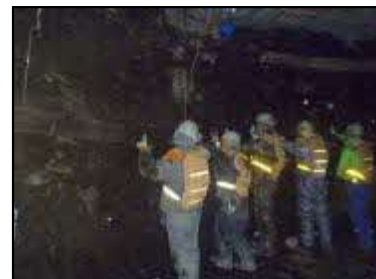
⑤鋼製支保
