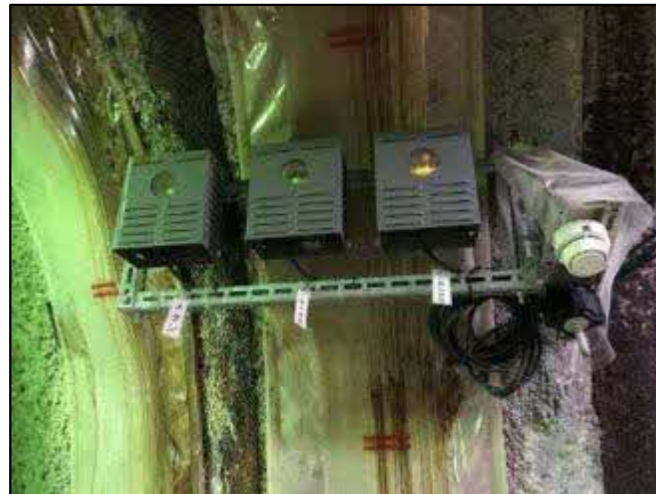
坑内監視システムによる24時間連続監視
