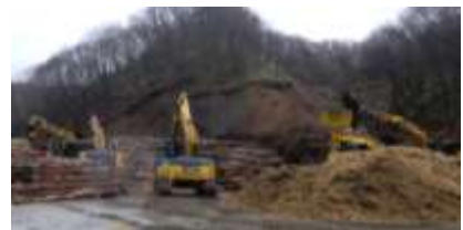
有効利用される被害木の集積状況（厚真町 幌内川流域）
