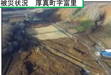
被災状況 厚真町字富里
