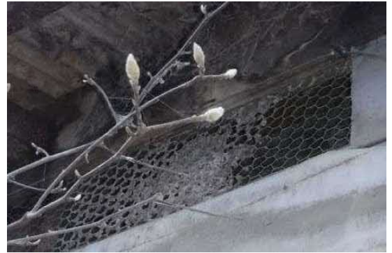
樹木の枝が伸びた先に、金網に埃がない場所があり、スズメ等の侵入口と思われる
