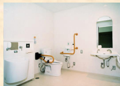
▲多目的トイレ
