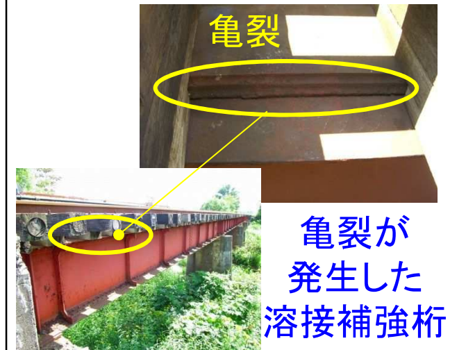
(例: 札沼線 知来乙・石狩月形間 須部都川橋りょう)
