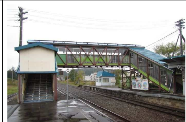
軟弱地盤上の乗換跨線橋
