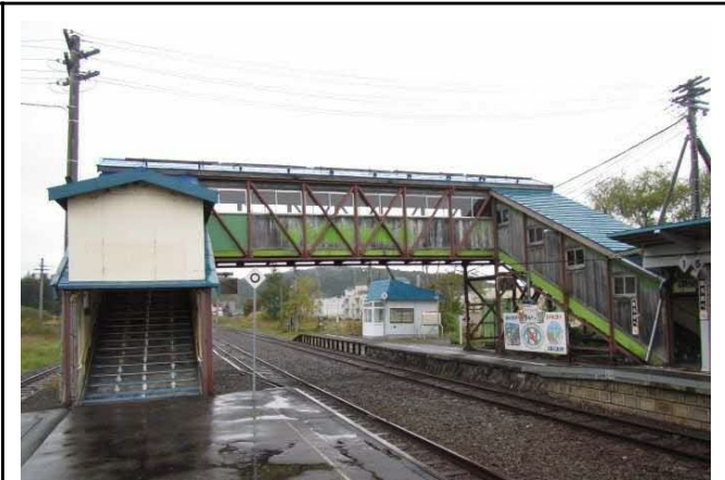
軟弱地盤上の乗換跨線橋
