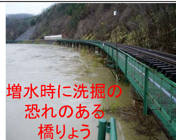
(例: 宗谷線 糠南・雄信内間 問平陸橋)
