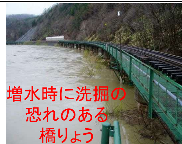
(例: 宗谷線 糠南・雄信内間 問平陸橋)
