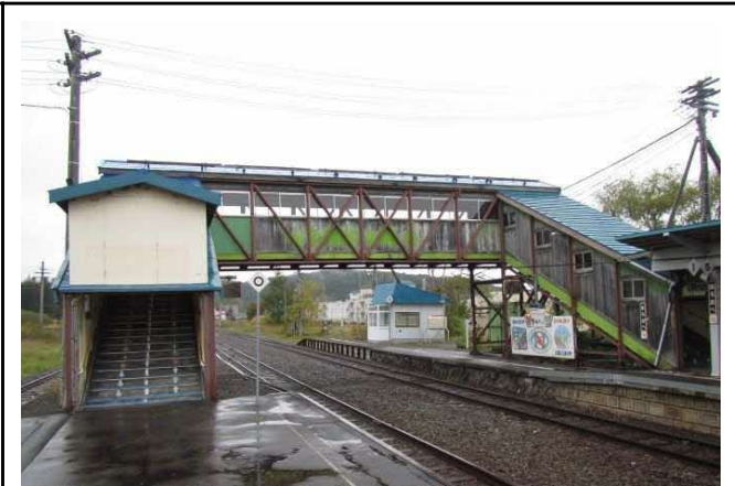
軟弱地盤上の乗換跨線橋
