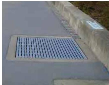
写真 II-2 グレーチング蓋の格子間隔を狭め、滑り止め加工している事例
