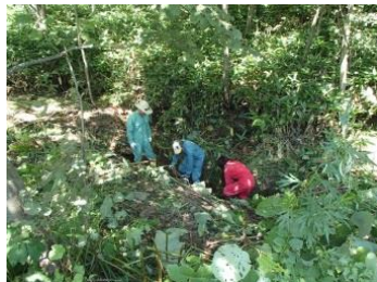
【排水路清掃作業】
