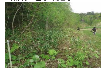
【電気柵の補修の様子】
