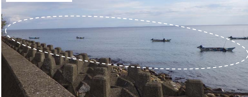
護岸前面の漁場
