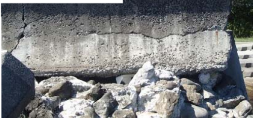
①老朽化による倒壊の恐れ
