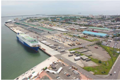
苫小牧港 複合一貫輸送ターミナル（西港区）
