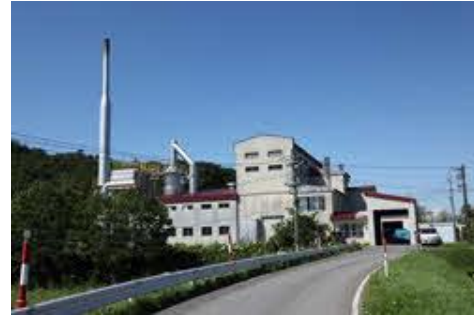
老朽化した焼却施設（厚岸町）
