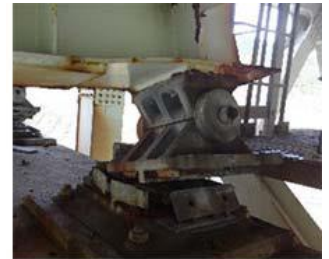
橋梁の支承・主桁の損傷 写真・国土交通省HP
