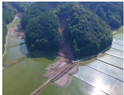
復旧状況 ほ場内に土砂を片寄せ(一時堆積)
