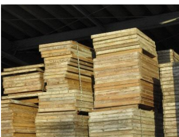
写真 C コンクリートが付着した型枠
