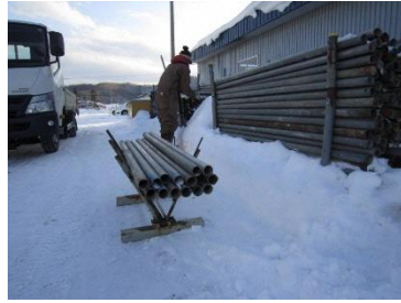
写真E 治具を用いて単管の束を作る
