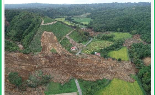
2018. 9. 6 地震災害 北海道胆振東部地震による道路被災
