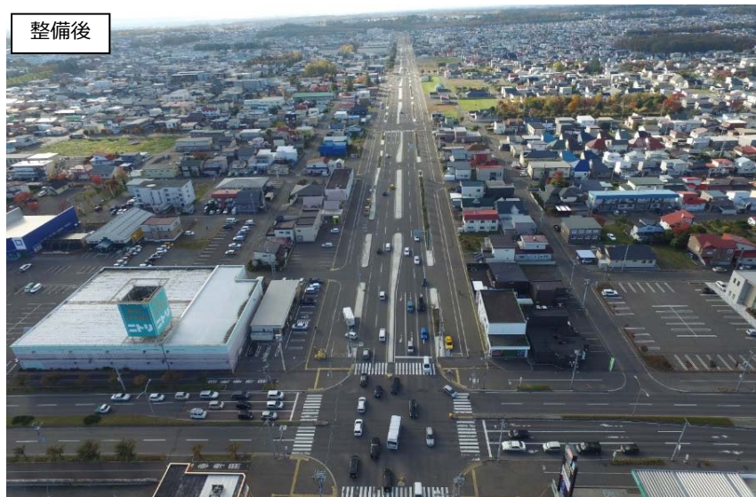
都市計画道路弥生新道（帯広市）
