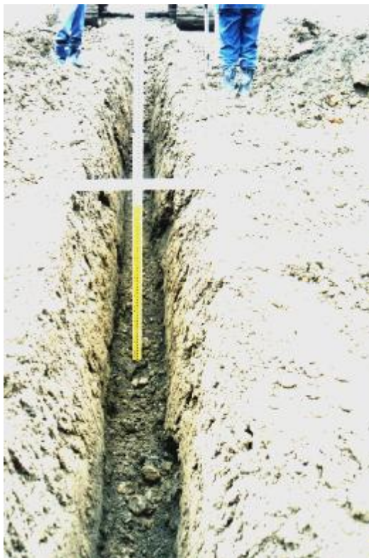
図 19-4 集水渠断面状況写真
