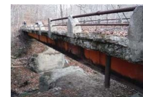
<林道橋梁の老朽化状況>
