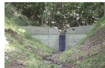
<治山ダムの整備>
