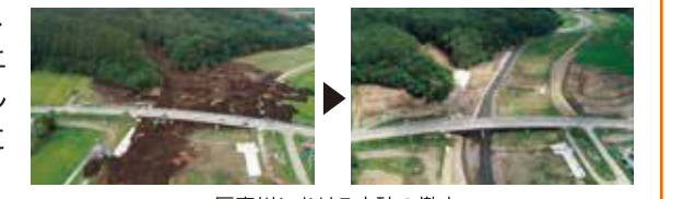
厚真川における土砂の撤去
