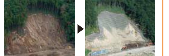
厚真町轄内地区の山腹崩壊の復旧状況
