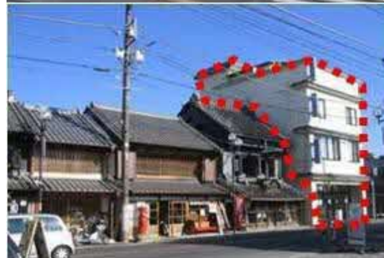
(例)まちなみの連続性が損なわれている様子 11
