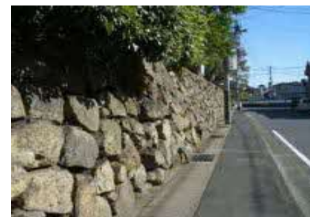
津山城宮川門跡石垣(津山市)
