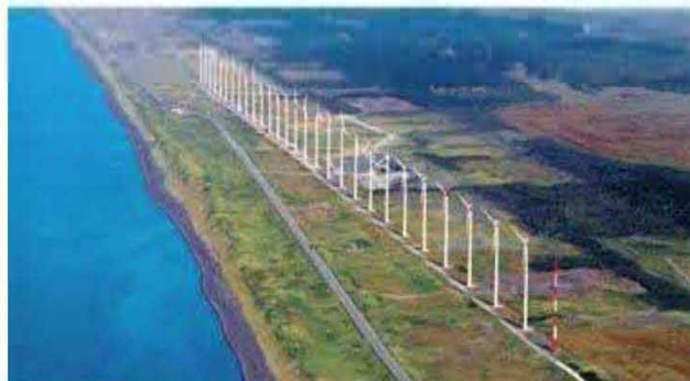
オトンレイ風力発電所、幌延風力発電(株)（出典：NEDO）
