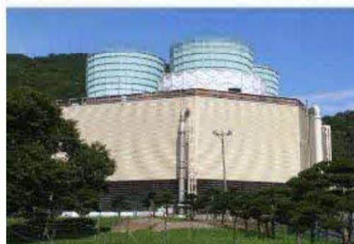
北海道電力(株) 森地熱発電所
