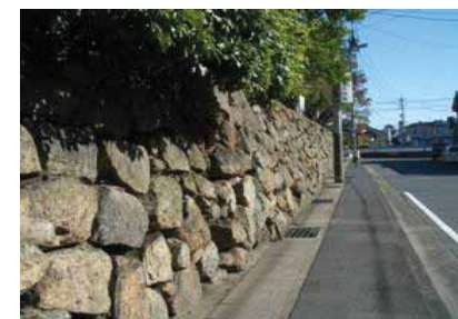
津山城宮川門跡石垣（津山市）
