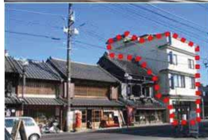
(例)まちなみの連続性が損なわれている様子 4
