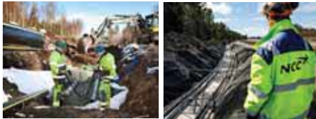
新規の高圧電線地中化
