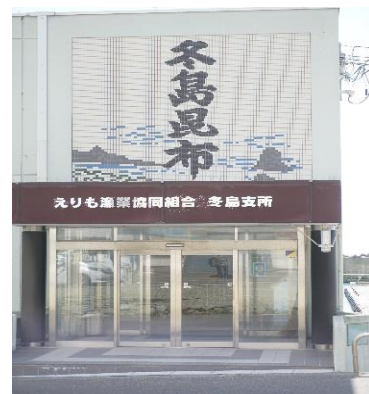
図4 現在の冬島支所の正面
