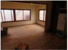
▲ 来年5月のオープンに向け内装工事中（写真下）。上の写真は外観。内装のフローリングには元厚真町地域おこし協力隊員が製材した板を使用。
