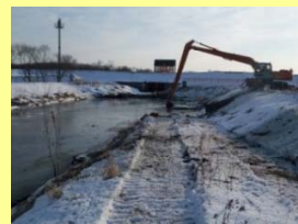
沈砂池の泥上げ (3年に1回(沈砂池数7))
