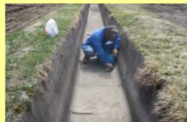
水路の目地補修
