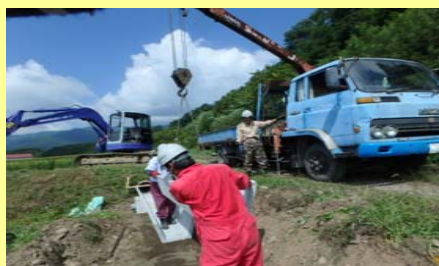
トラフの設置状況
