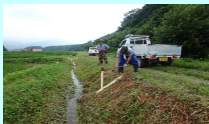
断面の復旧状況
