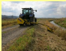
排水路法面の草刈
