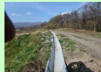
施工後の状況
