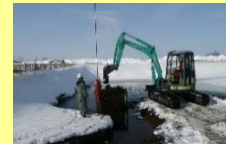
排水調整池の土砂の除去
