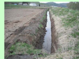
泥上げ実施後の水路
