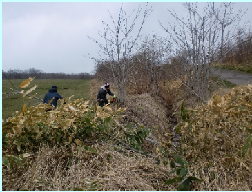
農道側溝の雑木伐採
