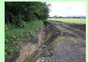
外注による水路の泥上げ
